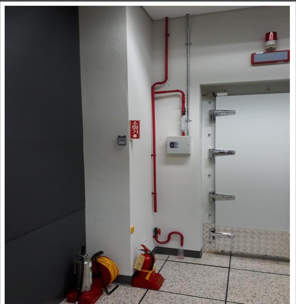
냉동창고 VLC-505 (공기흡입형감지기) 설치 사진
